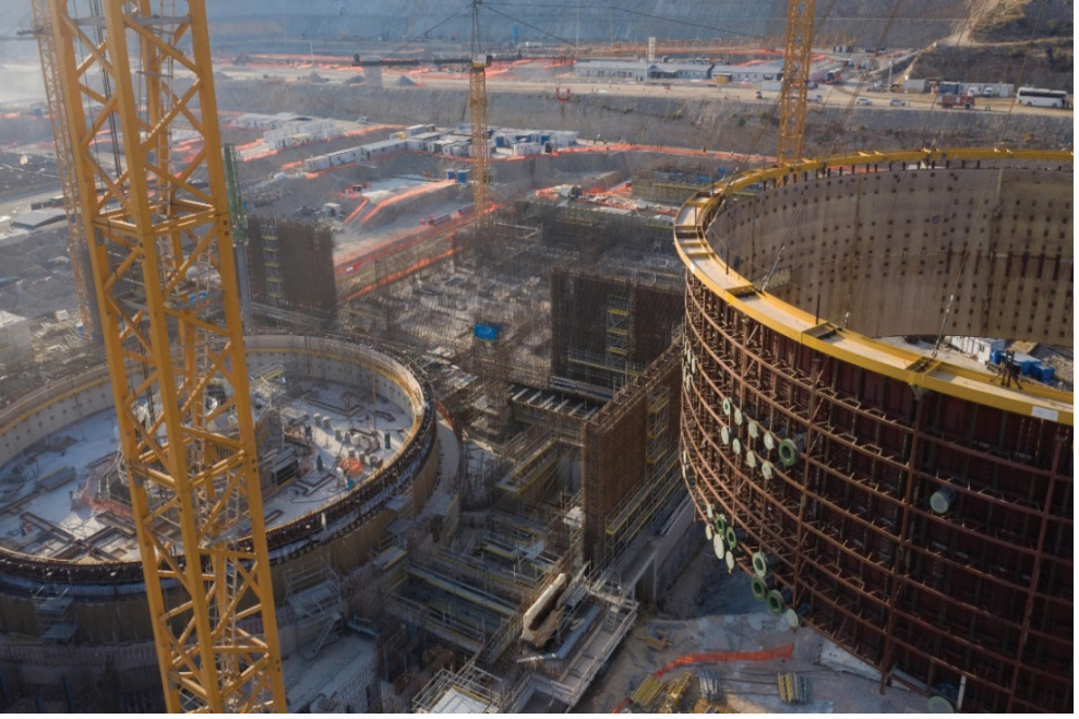
Şekil 7.1: Akkuyu Nükleer Santral inşaat faaliyetleri
