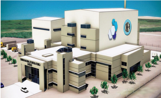
Şekil 4.6: CAREM SMR Binası [4.16]
