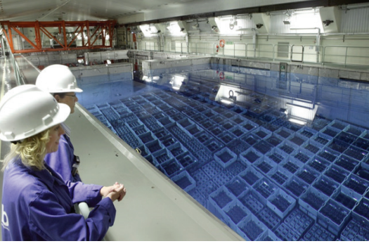
Şekil 5.3: İsveç Merkezi Geçici Depolama Tesisi (CLAB) [5.15]
