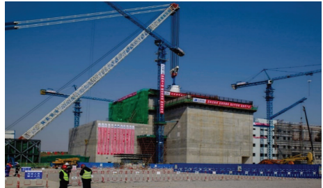
Şekil 4.15: HTR-PM nükleer santrali inşaatı [4.20]
